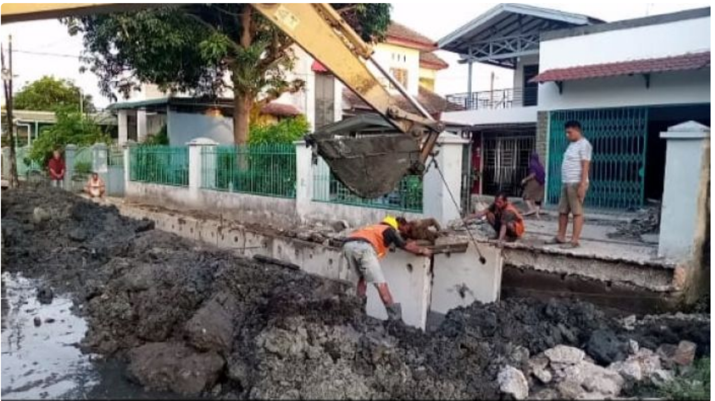
Pemasangan U-Ditch di Jalan Pelita VI dikeluhkan warga, Kamis (18/5).
